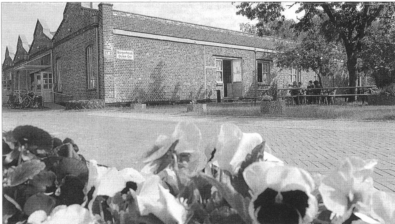
Die alte Papier verarbeitende Fabrik Becker und Funck wird zum Kultur-, Bürger- und Dienstleistungszentrum umgebaut. Die Arbeiten können jetzt beginnen – das Land NRW sagte zu, das Projekt mit 80 Prozent zu bezuschussen. Fotos: Ingo Latotzki
